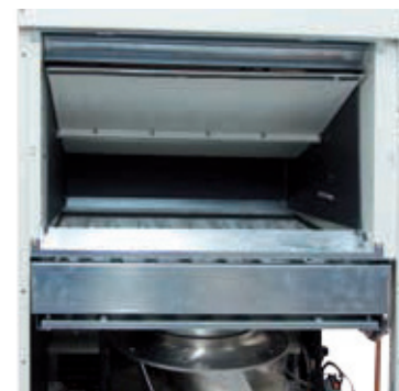
Заслонка кондиционера свободного охлаждения телекоммуникационного оборудования мобильной связи
